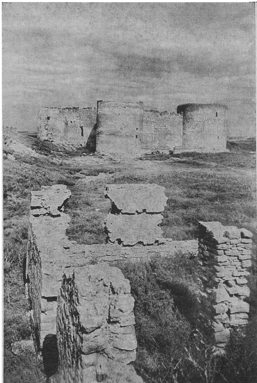
Fig. 113. — Ruinele Cetății Albe. Fortul Central.
