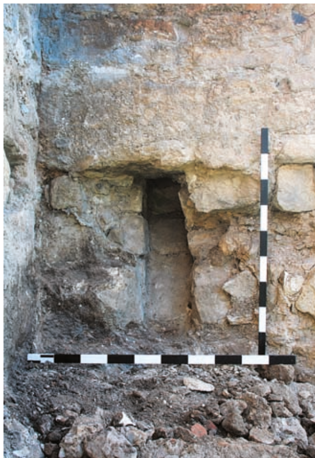
Fig. 7. Scurgerea de latrină descoperită la o degradare de zid, la picior de turn (foto A. A. Rusu)
