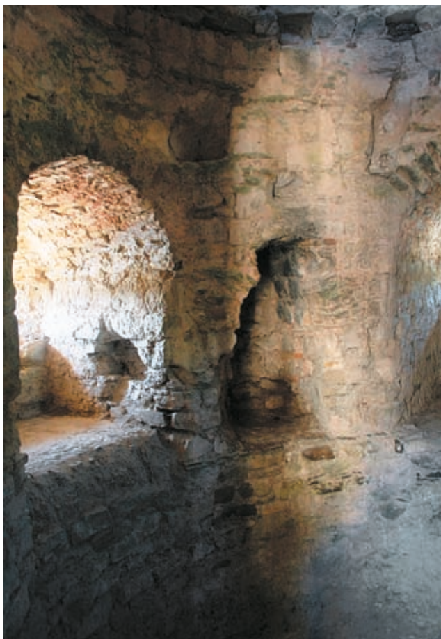
Fig. 6. Locaș de latrină din interiorul turnului (foto A. A. Rusu)
