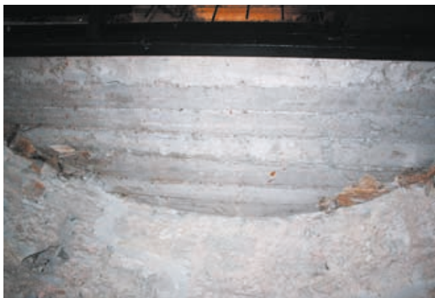
Fig. 9. Noul planșeu de beton apărut în cetate (foto A. A. Rusu)
