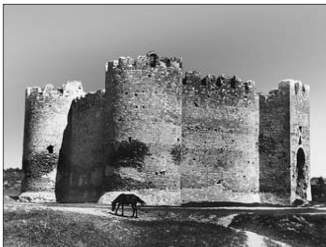
Fig. 11. Imaginea cetății din 1945, se vede reparația părților inferioare ale zidurilor cetății. Fotograf L. Raskin, ANRM.
