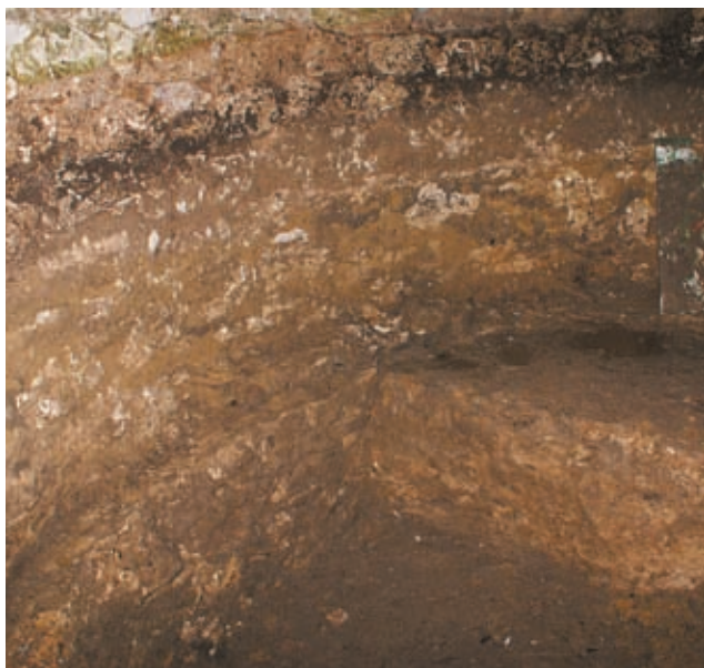
Fig. 9. Turnul I - Secțiunea 3: Fundația zidului de curtină suprapusă de fundația Turnului I.
